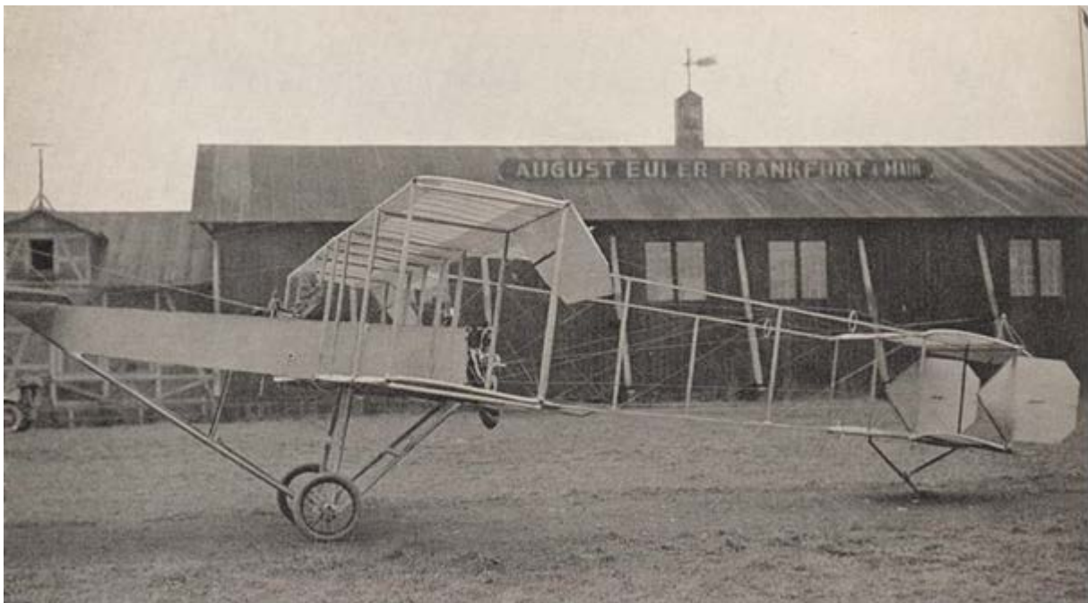
Abb. 2: Erste Flugzeughalle und Pilotenhaus in Darmstadt Griesheim – das Schild auf dem Dach weist auf Eulers Firmensitz in Frankfurt hin.
